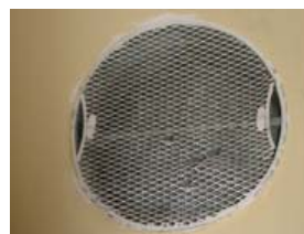
Pivohängd röklucka i spirorör
