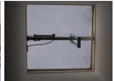
Samma lucka sedd underifrån med gasfjädrar och hållmagnet.
