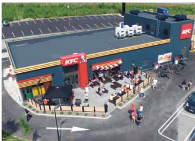
NSP driver ett 60-tal snabbmatsrestauranger i Sverige och Danmark. Från att ha fokuserat på teknik i det systematiska brandskyddsarbetet, som korrekt underhåll av utrustningen, inriktar sig företaget nu också på organisatoriska delar.
