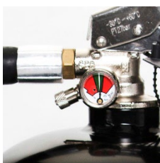
Ventilen är försedd med en lättavläst manometer
