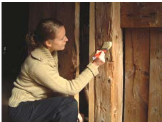
På trä påförs Exfire flamskyddsmedel enklast med pensel. Behandlingen ska ske två gånger.
